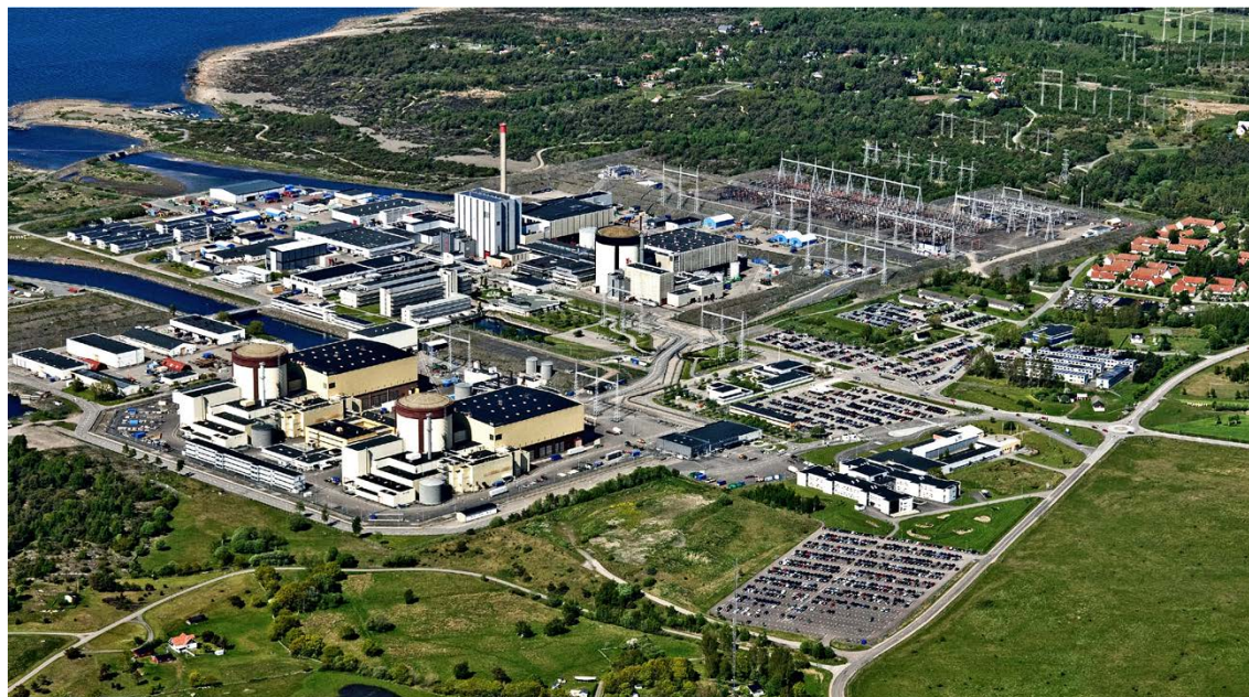
Figur 16-1. Ringhals kärnkraftverk med reaktor R1 och R2 ovanför reaktor R3 och R4 i figuren. I centrum av förläggningsplatsen finns bland annat kontorslokaler och lunchrestaurang. Strax till vänster om R1 i figuren syns verkets avfallsområde vilket inkluderar hantering, konditionering och lagring av kärnavfall.
