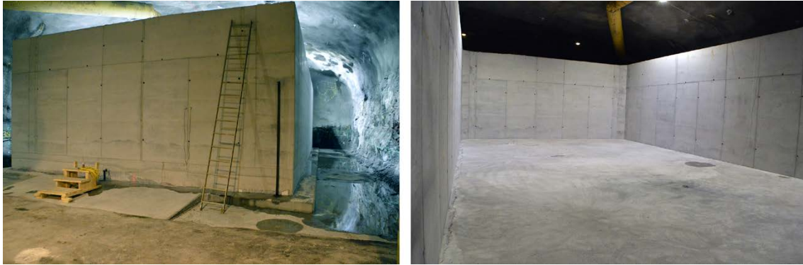
Figur 9-1. Gjuten kassun i Äspölaboratoriet, ut- och insida (Mårtensson och Vogt 2020).
