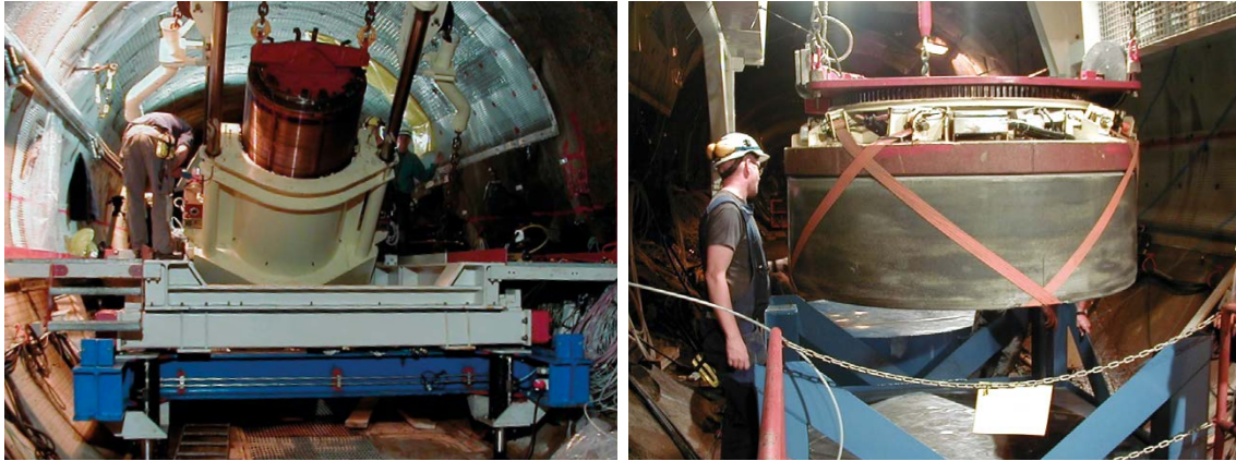
Figur 4-1. Foton från Prototypförvarets installation tidigt 2000-tal. Till vänster, en kapsel som placeras i ett deponeringshål. Till höger, ett buffertblock som ska placeras i ett deponeringshål.
